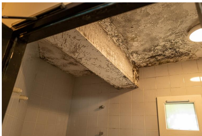
Salle d'eau du rez-de-chaussée
