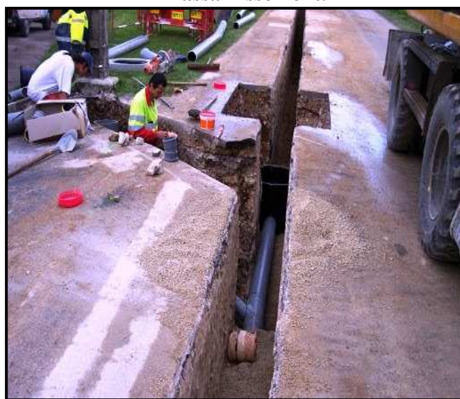
Photographie. 16: Pose de canalisation D'assainissement.
