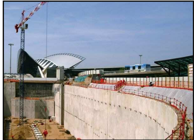
Photographie. 06: Rideau de palplanches métalliques. Photographie. 07 : Paroi coulée. Source : www.google.fr/images/palaplanchesmétalliques Source : www.google.fr/images/paroioulée
