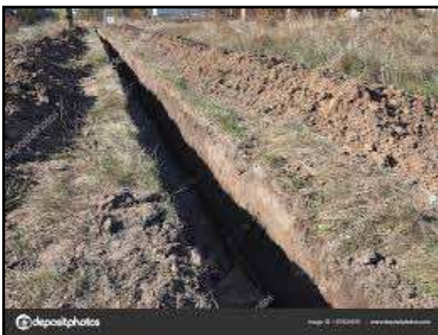
Photographie. 18 : Excavation d'une tranchée
