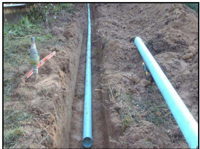
Photographie. 19 : Pose d'une canalisation
