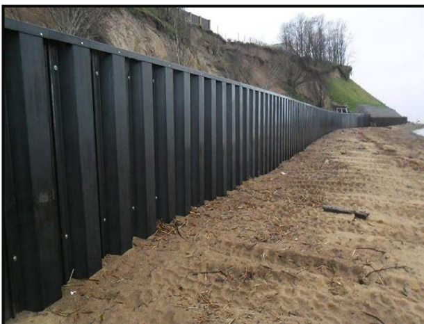
Photographie. 06: Rideau de palplanches métalliques. Photographie. 07 : Paroi coulée. Source : www.google.fr/images/palaplanchesmétalliques Source : www.google.fr/images/paroioulée
