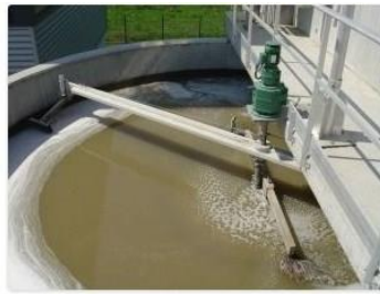
Ouvrage de dessablement
