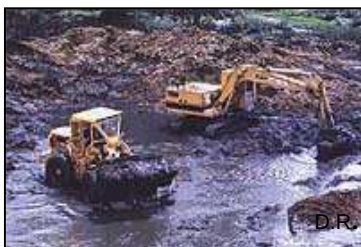
Travaux de nettoyage
