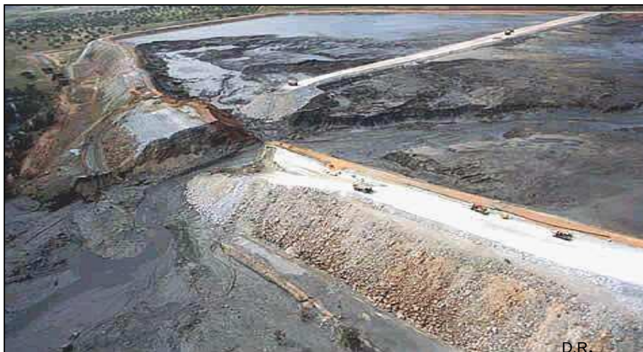
Vue aérienne du bassin de stockage
