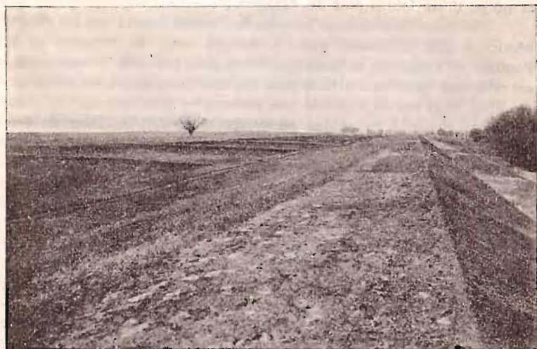
Fig. 23. Une digue contre les inondations du Danube dans la plaine de Vidine.
